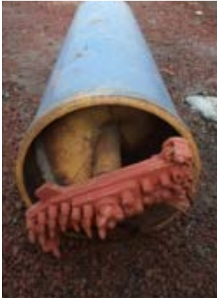
Hincado de tubería
