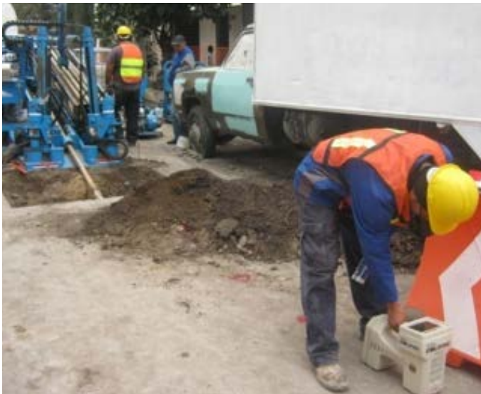
Perforación Horizontal Dirigida (Horizontal Directional Drilling - HDD)
