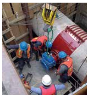
Instalación de válvula de compuerta de 12" a TEE partida de acero montada sobre tubo de concreto de 48" de Ø.
