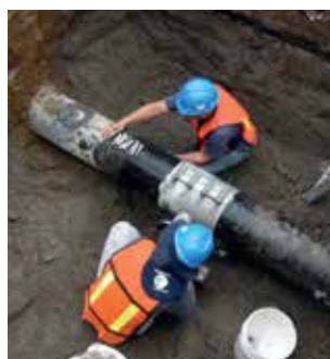
Prueba hidrostática para garantizar hermeticidad de la instalación de la válvula, TEE partida y la unión de la válvula de 4" de Ø a la TEE partida de acero.
