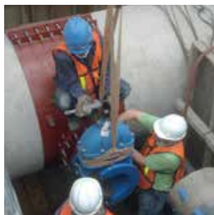
Instalación de válvula de compuerta de 12" a TEE partida de acero montada sobre tubo de concreto de 48" de Ø.
