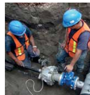
Instalación de TEE partida de acero a la tubería de PEAD de 12" de Ø.
